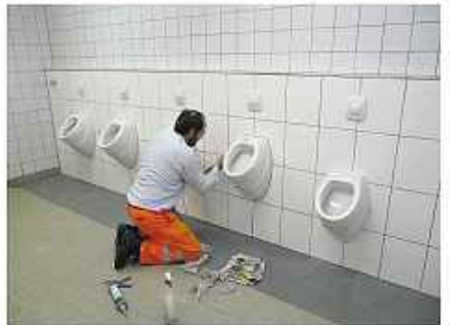
Erneuerung der Knaben-WC-Anlage in der Schule
