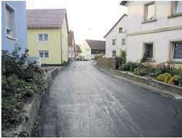
Erneuerung der Ortsstraße in Seelig
