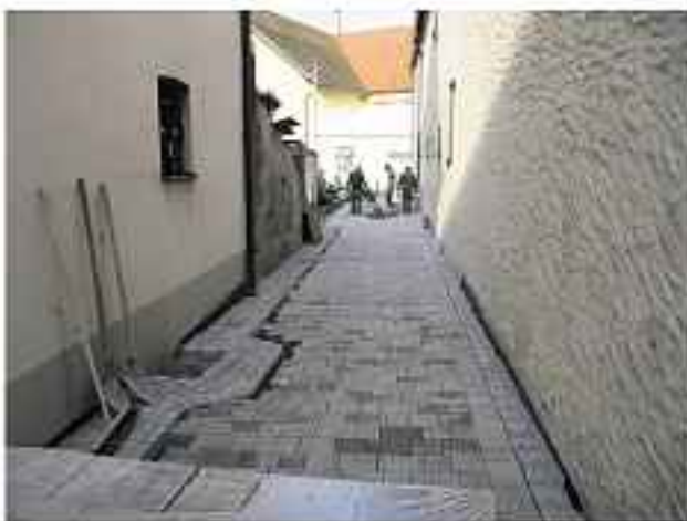
Neuer Fuß- und Rollstuhlfahrerweg beim Anwesen Huppmann/Söllner
