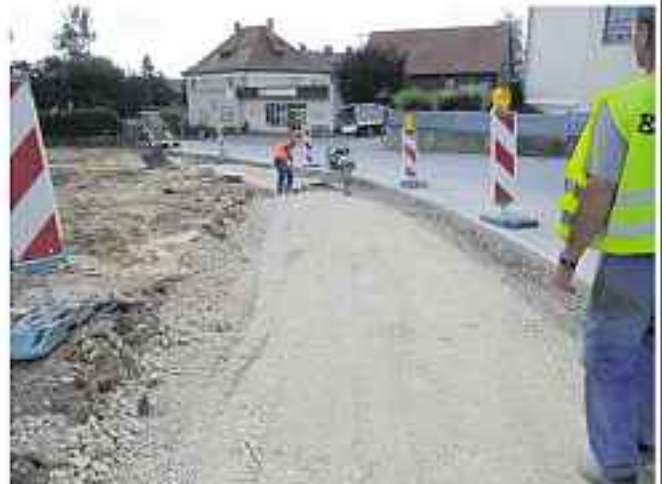
Neuanlage des Gehweges in Breitenlesau entlang der Staatsstraße
