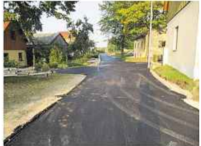
Neubau einer Ortsstraße in Seelig
