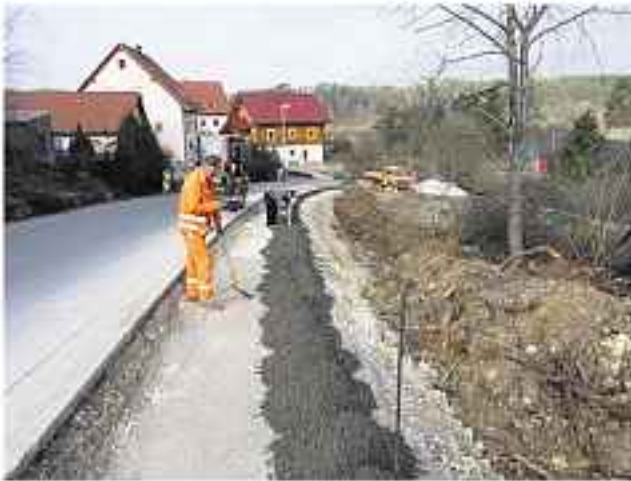
Errichtung eines Gehweges in Waischenfeld-Nord
