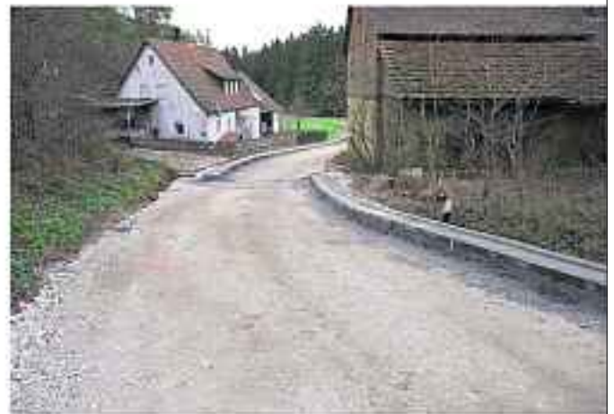
Neuer Zufahrtsweg in Goldhof kurz vor der Teerung
