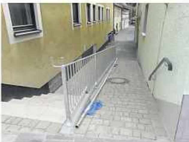
Neue Treppenanlage und Rollstuhlfahrweg neben der Metzgerei Junk
