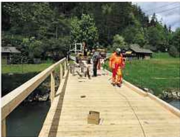
Neubau der Brücke in Rabeneck
