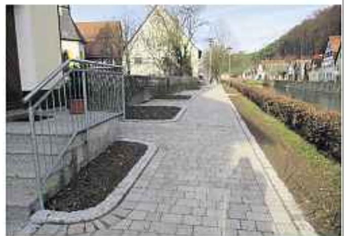
Neuer Fußweg entlang der Wiesent bis zum Parkplatz
