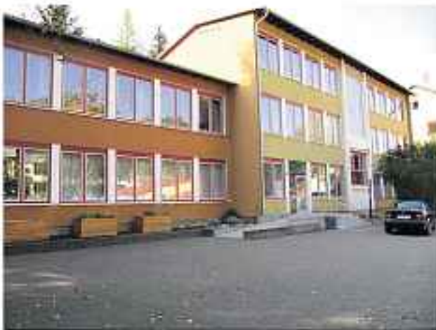
Erneuerung der Fenster in der Grundschule Waischenfeld
